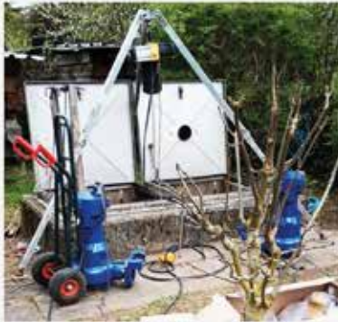
Kirchenfeld: Austausch Pumpe Hebewerk
