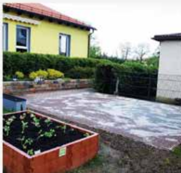
Kindergarten: Pflasterarbeiten für den Kinderwagen-Stellplatz sind fertig
